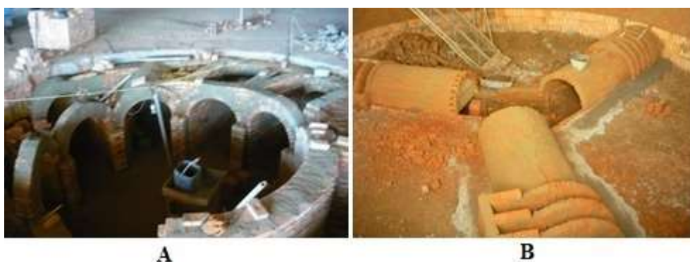
Figura 7 – Forno antes da reengenharia (7A) e após a reengenharia (7B).
